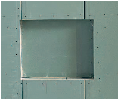
Fig. 28: Niche habillée de plaques GKBI
