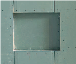
Fig. 12: Niche habillée de plaques GKBI
