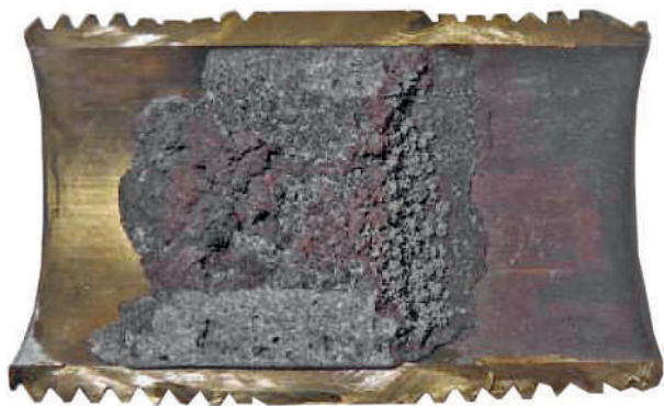
Fig. 38: Dommages par des dépôts de calcaire dans les raccords en laiton (photo: notice technique Suissetec W10019)
