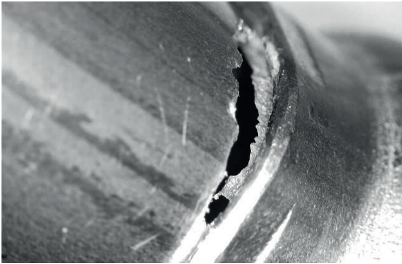
Fig. 15: Dommages par corrosion par piqûres
