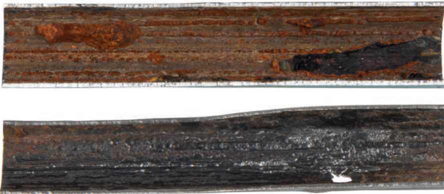
Fig. 12: La photo montre les dommages que la corrosion surfacique a causés sur un tuyau en acier au carbone. Photo du haut: vue du tuyau avec les produits de corrosion. Photo du bas: le même tuyau débarrassé des produits de la corrosion.
