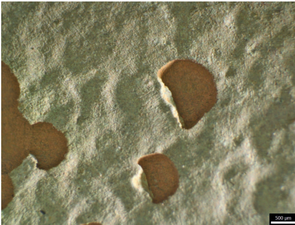
Fig. 21: Détail des dommages causés, avec des dépressions en forme de fer à cheval, caractéristiques de la corrosion par érosion.
