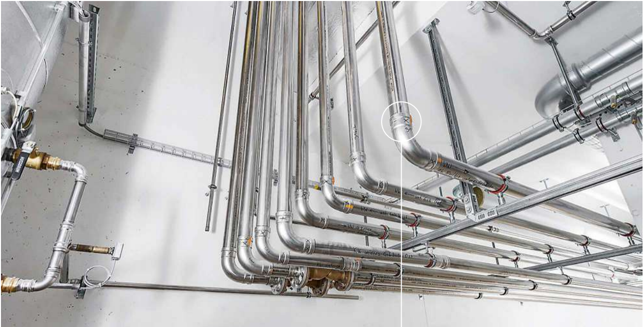
Abb. 4: Montierte Pressfittings mit Optipress-Aquaplust-Verbindungen
