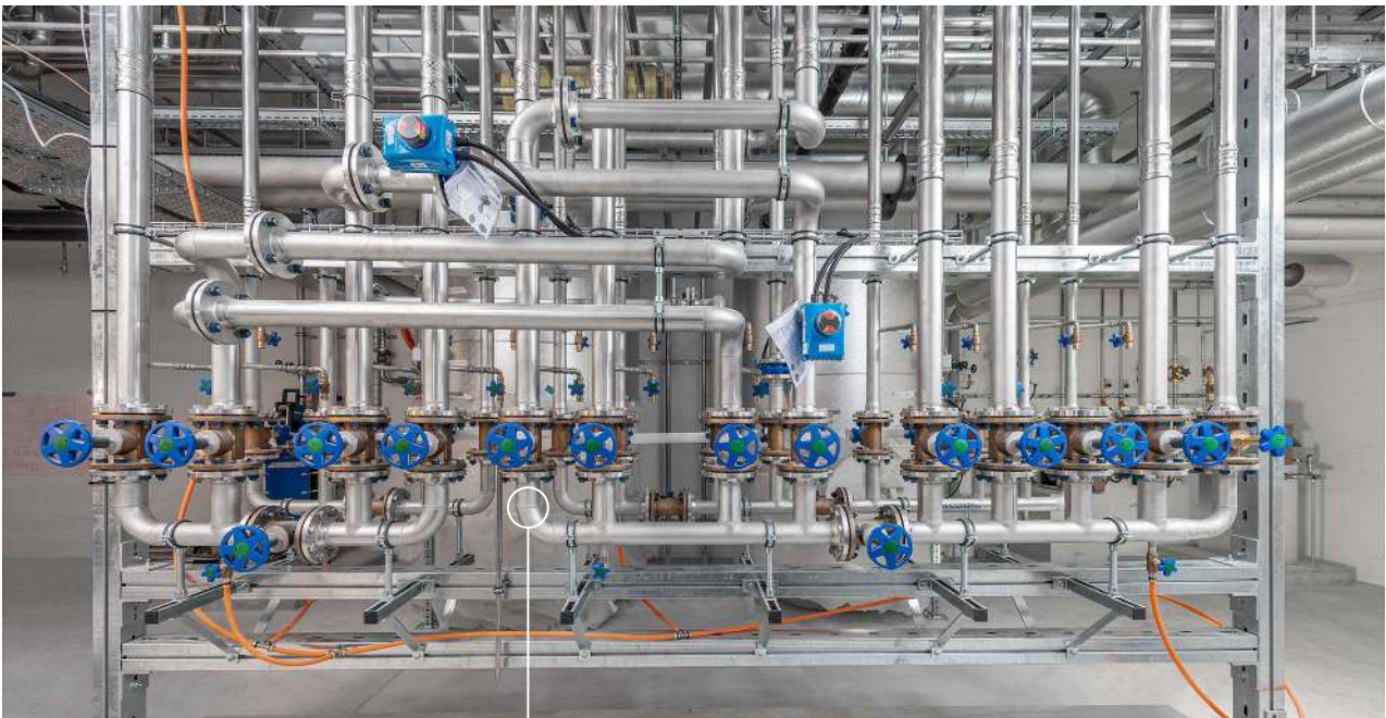
Abb. 19: Eine von vielen Schweissverbindungen in einer Edelstahl-Verteilerbatterie
