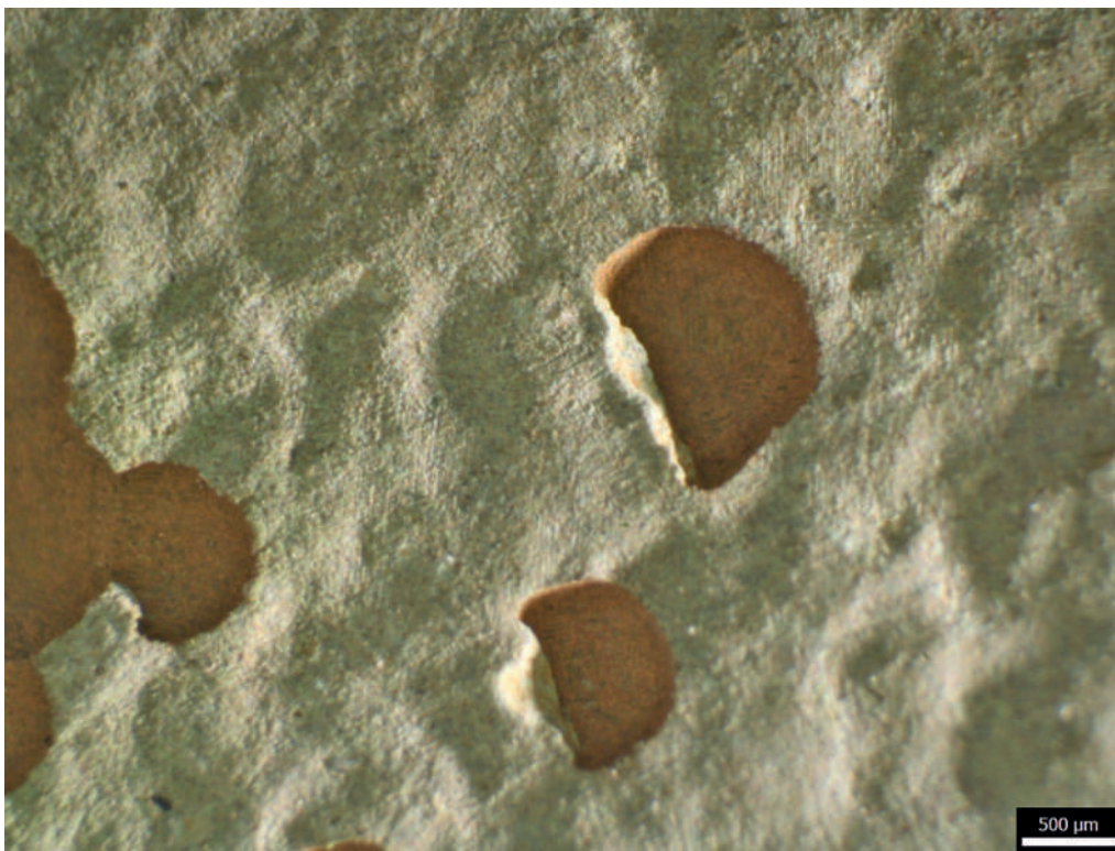
Abb. 21: Detail des Schadensbildes mit den hufeisenförmigen Mulden, die für Erosionskorrosion charakteristisch sind.
