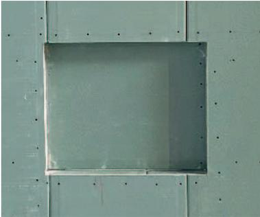
Abb. 28: Nische mit GKBI-Platten ausgekleidet
