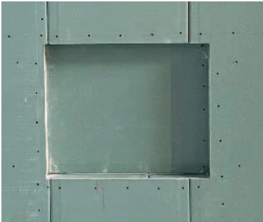
Abb. 28: Nische mit GKB-Platten ausgekleidet
