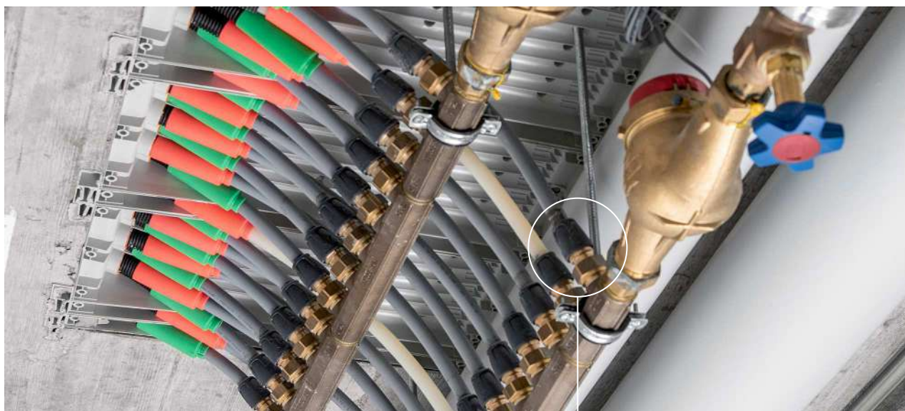
Fig. 9: Collegamenti Optiflex-Profix su un distributore
