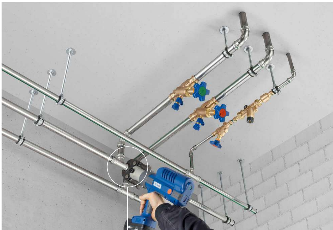
Fig. 2: Realizzazione di un raccordo a pressare Optipress-Aquaplus
