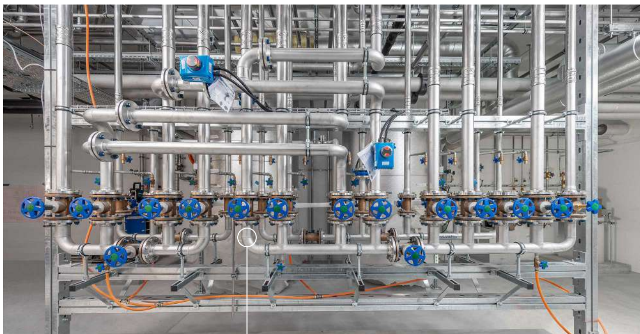
Fig. 19: Uno dei numerosi collegamenti a saldare in una batteria di distribuzione in acciaio inossidabile
