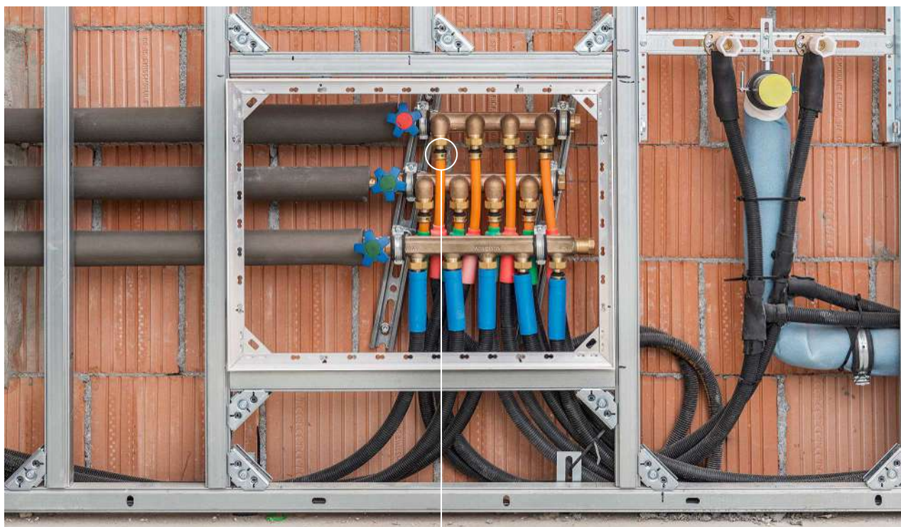
Fig. 7: Collegamenti Optiflex-Flowpress in una distribuzione sui piani montata
