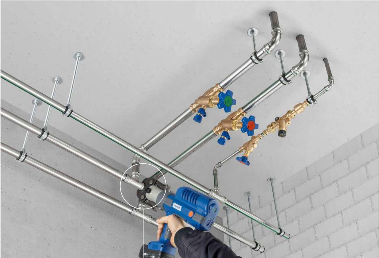
Fig. 2: Realizzazione di un raccordo a pressione Optipress-Aquaplus
