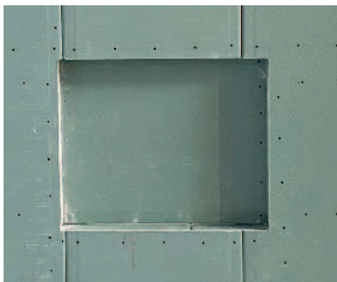
Fig. 28: Nicchia rivestita con pannelli GKBI.
