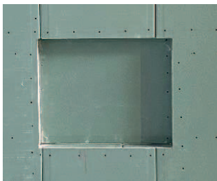
Fig. 12: Nicchia rivestita con pannelli GKBI.
