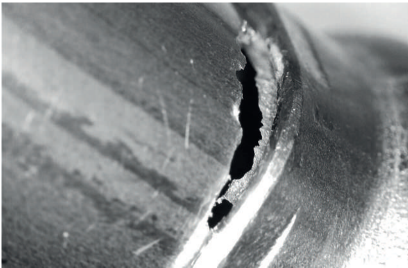
Fig. 15: Immagine del danno dovuto a corrosione per vaiolatura.
