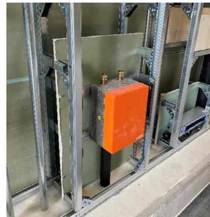
Figure 5: Boîte UP installée dans un mur sanitaire des deux côtés. Une plaque de plâtre sépare les boîtes UP.
