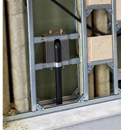
Figure 3: Boîte UP installée sur un côté dans un mur sanitaire.
