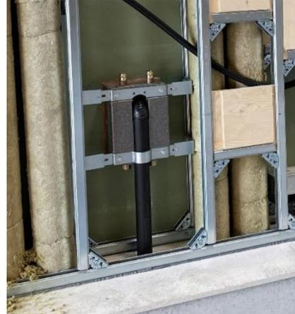
Bild 3: UP-Box einseitig in Sanitärwand eingebaut.
