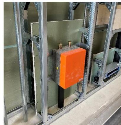
Bild 5: UP-Box beidseitig in Sanitärwand eingebaut. Eine Gipsplatte trennt die UP-Boxen
