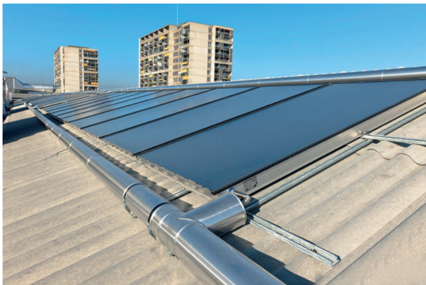
Fig. 7: Installazione di un impianto solare a collettori piatti sul tetto con Optipress.
