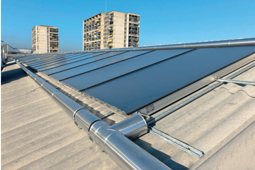
Abb. 7: Installation einer Flachkollektoren-Solaranlage auf dem Dach mit Optipress
