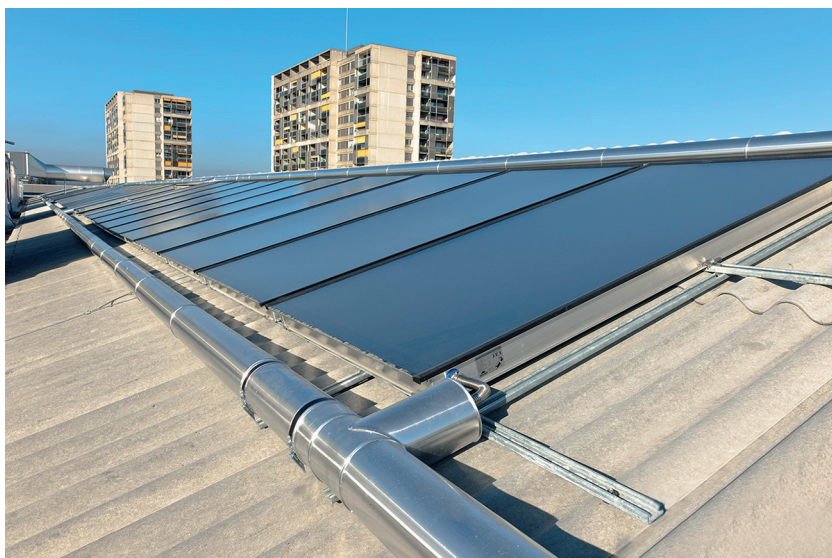
Fig. 7: Installation solaire à capteurs plans sur un toit avec Optipress
