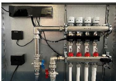
Installation rapide : tous les composants de Therm-Control peuvent être intégrés dans le boîtier de distribution existant du chauffage au sol.
