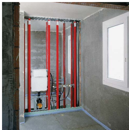
In sämtlichen Nasszellen der Überbauung kam das flexible Vorwandsystem Optivis zum Einsatz.
