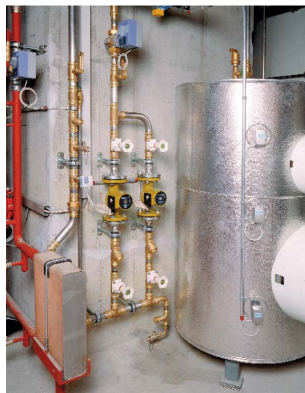
Ankoppelung der Warmwasser-Umlaufzirkulation
