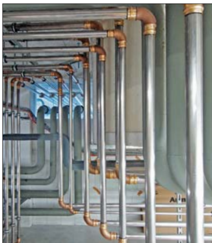
Optipress dans les zones ascendantes de la centrale principale TZ 12
