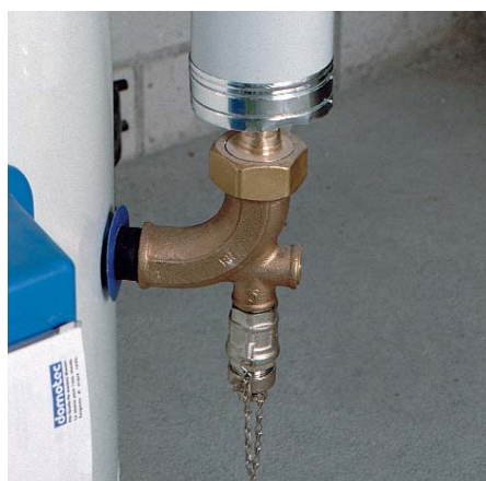
Die systemneutrale und in jeder Richtung einsetzbare Boiler-Anschlussgarnitur mit Kesselentleerungshahn.
