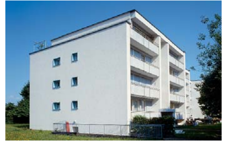
Der 4-geschossige Wohnblock «Rhyblick» in Sisseln/AG.
