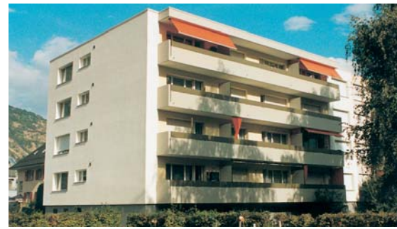
Der renovierte Block mit 12 Wohnungen im Kleeärtenquartier von Visp.
