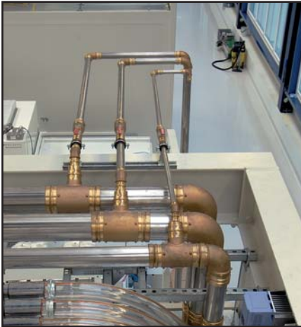
Optipress, das montagefreundliche und wirtschaftliche Sanitär-Installationssystem, basiert auf modernster Pressverbindungstechnik
