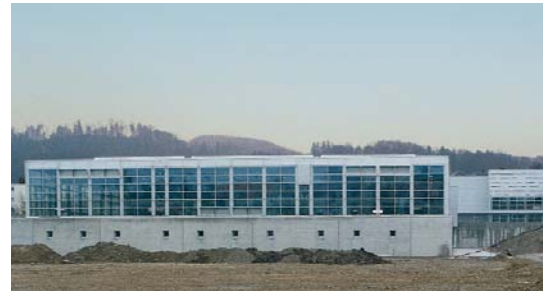
Die neue Dreifachturnhalle in der Schulanlage «Botsberg», Flawil.
