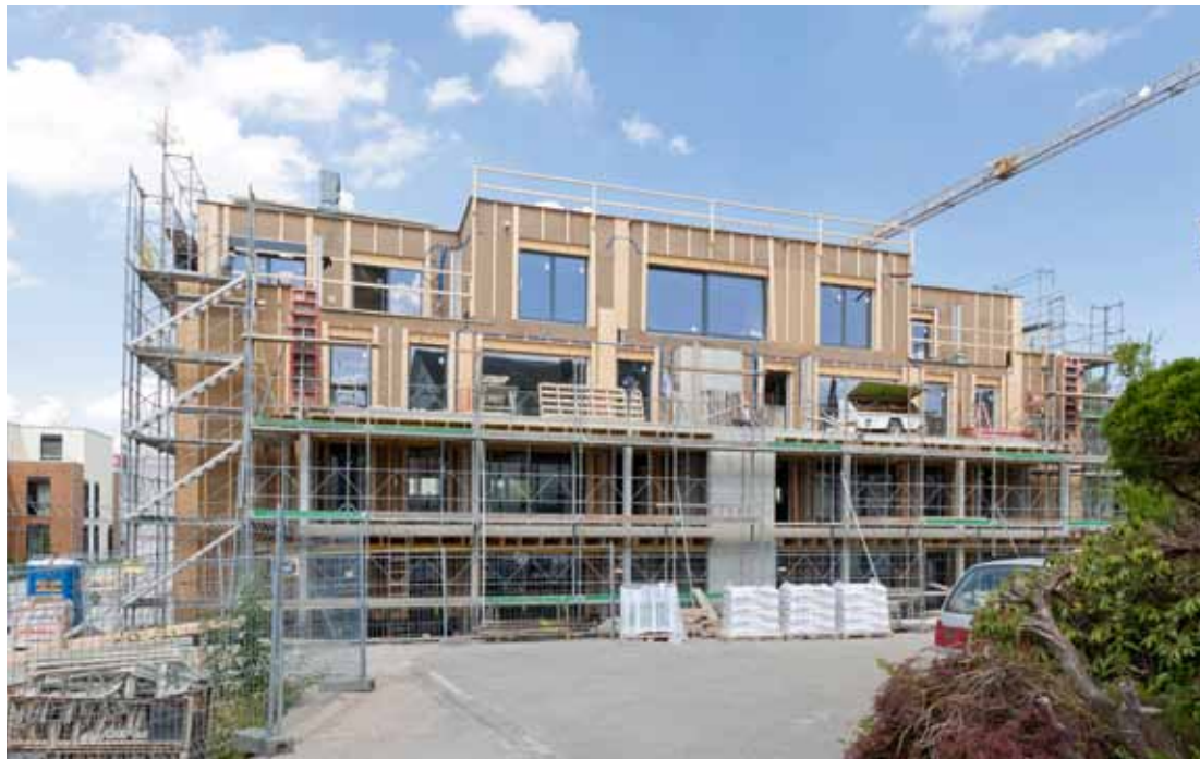
L'edificio dopo l'installazione della tecnica sanitaria.
