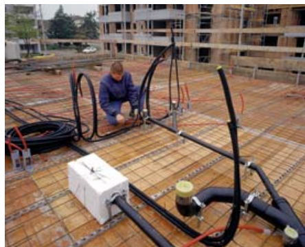
Posa delle tubazioni di distribuzione finale Optiflex.
