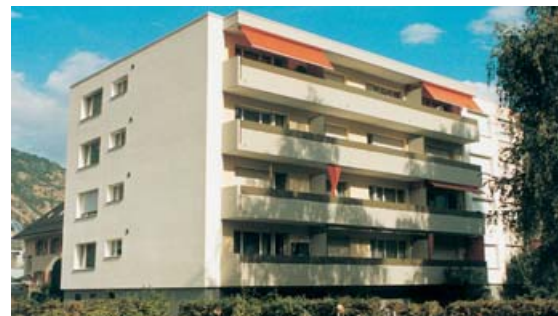
Il condominio, ristrutturato, di 12 appartamenti nel quartiere Kleegärten di Visp.
