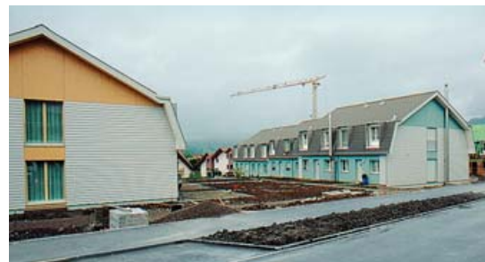
Il centro residenziale Platanenhof, realizzato in stile nordico, comprende 4 schiere di case per un totale di 24 unità abitative monofamliari.
