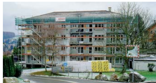
Il condominio costruito quasi 40 anni fa durante i lavori di risanamento totale.
