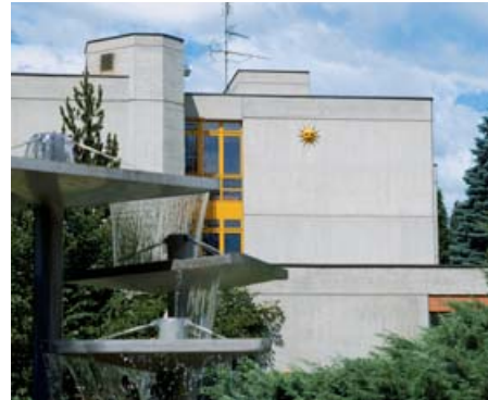
La nuova sede dell'istituto professionale artigianale di Visp, con i collettori solari installati sul tetto.
