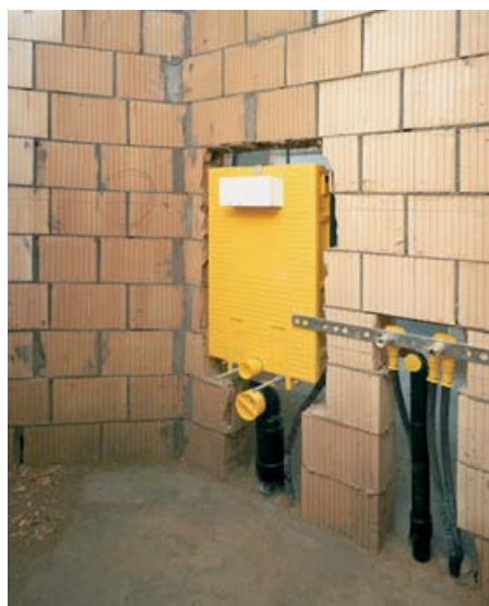
Nei WC separati è stato installato l'elemento WC Optibloc.
