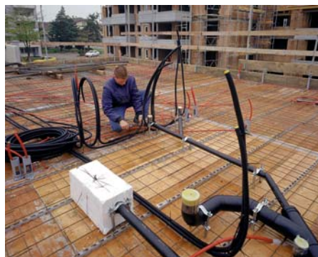
Pose des conduites Optiflex en dalle pour la distribution dans les appartements.
