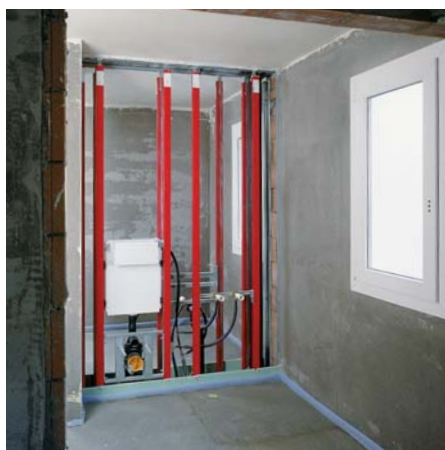
Tous les blocs sanitaires du complexe résidentiel ont été réalisés avec le système de cadre de montage Optivis.
