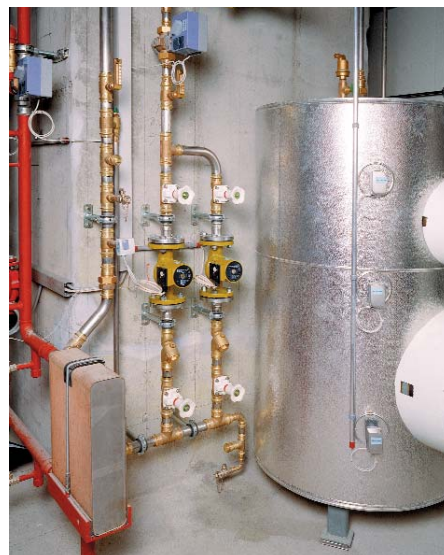
Accoppiamento del circuito dell'acqua calda.
