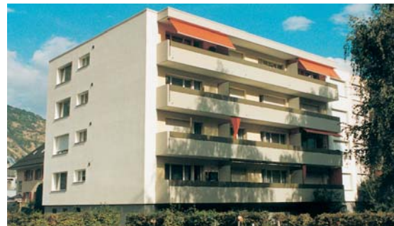
L'immeuble de 12 appartements après rénovation, situé dans le quartier Kleegärten de Viège.
