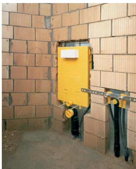
Les WC séparés ont été réalisés avec l'élément WC Optibloc.
