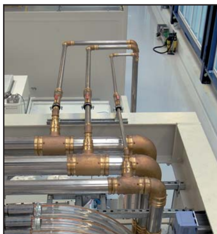
Optipress: il sistema di installazione di impianti sanitari economico e facile da montare, basato sulla più avanzata tecnica di connessione a pressatura
