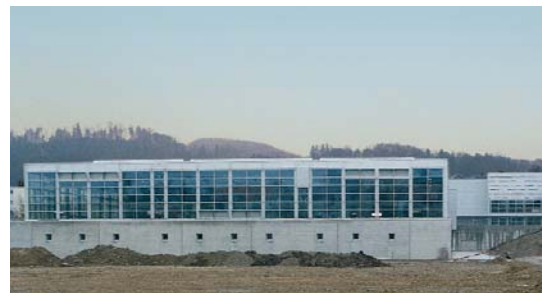
La nouvelle salle omnisports du complexe scolaire «Botsberg», Flawil.
