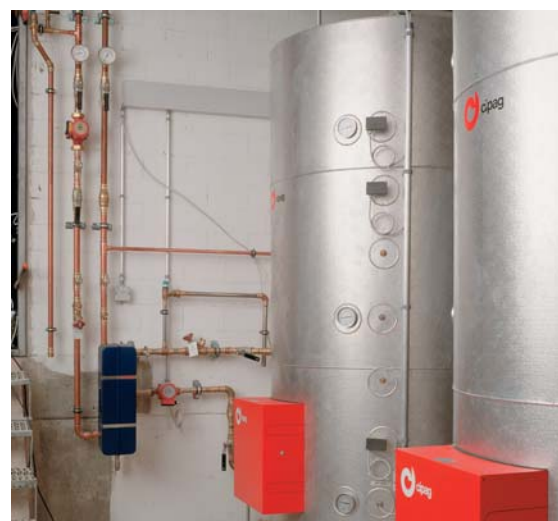
I due boiler dell'impianto solare con le condutture d'alimentazione e di uscita, realizzate con il sistema di installazione Cupress.
