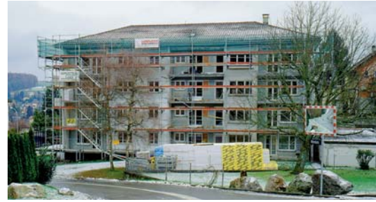
Le bloc de logements datant de près de 40 ans durant la rénovation complète.
