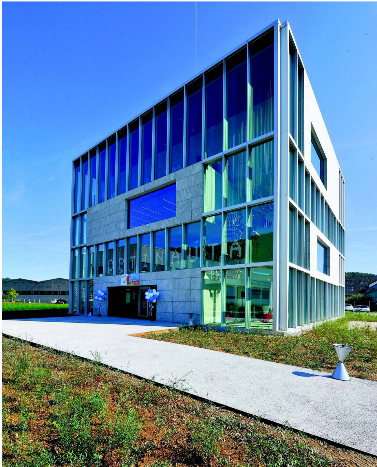
Das neue Kundenhaus «Optinauta» der R. Nussbaum AG in Trimbach setzt einen markanten Akzent.
